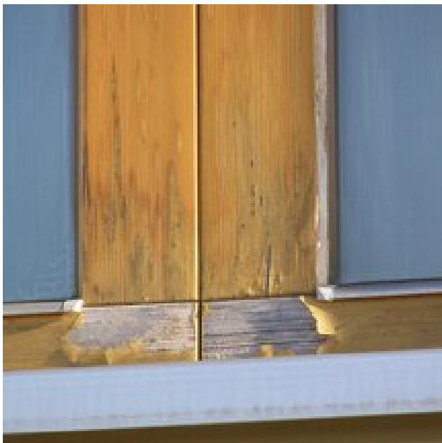
Jemné, neviditelné vlasové trhlinky lze uzavřít použitím ADLER Pflegeset-Plus jednou ročně. Pokud však mají vaše okna rozsáhlejší poškození, jako např. po krupobití, nebo dokonce zašedla a nátěr se olupuje, je nezbytná renovace. Podrobný návod na renovaci oken naleznete v části [Tipy & triky pro renovaci oken renovačním systém ADLER Pullex-Renoviersystem](#).
